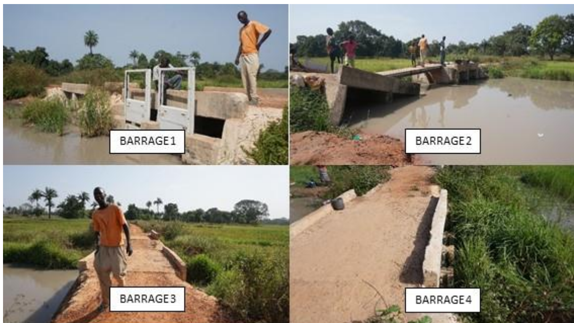
Figure 61 - Structures hydrauliques de la vallée de Ndiama.
