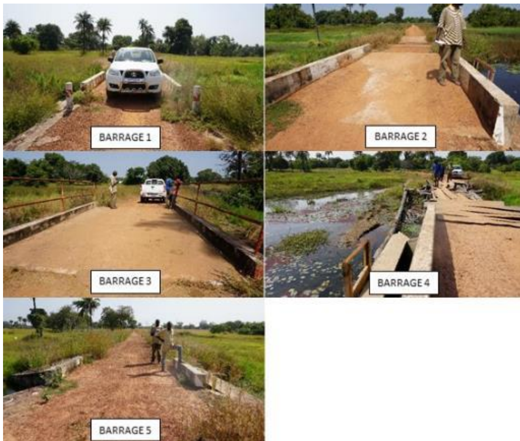
Figure 9 - Structures hydrauliques de la vallée de Bagadadji.
