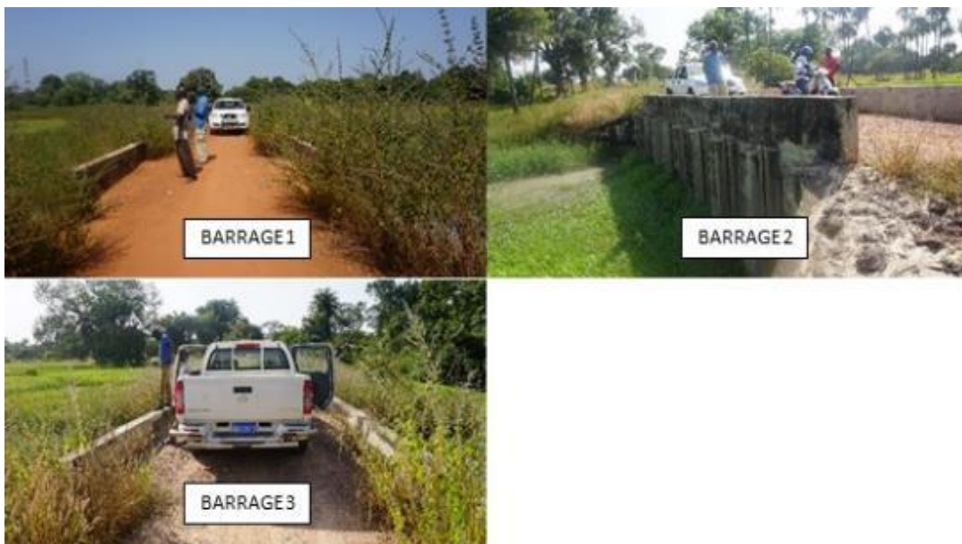
Figure 80 - Structures hydrauliques de la vallée de Tamignel Fere.
