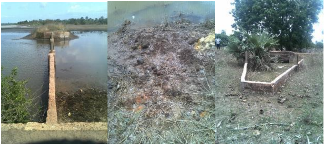
Figure 76 - Digue anti-sel de la vallée de Sindina (gauche) ; traces de sel autour de la route latéritique (centre) ; barrage (droite).
