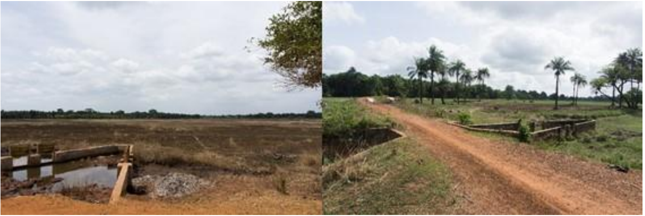
Figure 15 - Ouvrages de gestion hydraulique de la vallée de Bambali: digue anti-sel (gauche) et barrage (droite).
