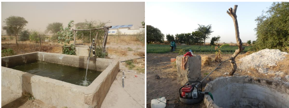
Fig. 31 - Exhaure d'eau à travers des motopompes à Keur Kab (gauche) et à Ndiamane (droite)
