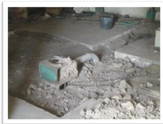
Figure 7 - Mbassis : détail du forage
