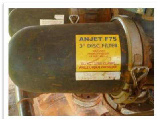
Figure 18 - Ngomène : filtres à disque
