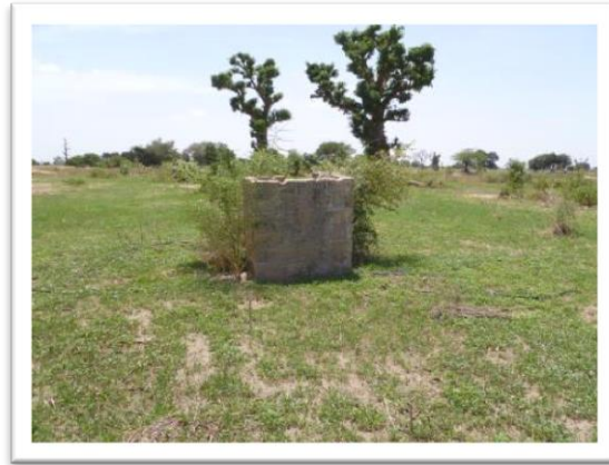
Figure 13 - Ngoyé : particulier de plateforme surélevée où les barils étaient placés
