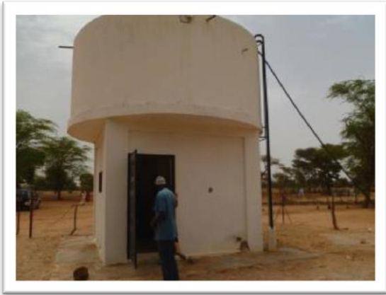
Figure 24 - Périmètres UGPM : château d'eau au champ
