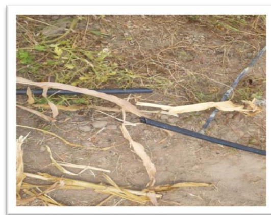
Figure 31 - Darou Samb : dégâts au réseau primaire d'irrigation
