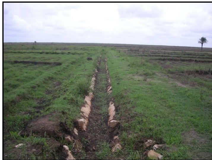
Figure 2. Ensablement et enherbement du canal de drainage
