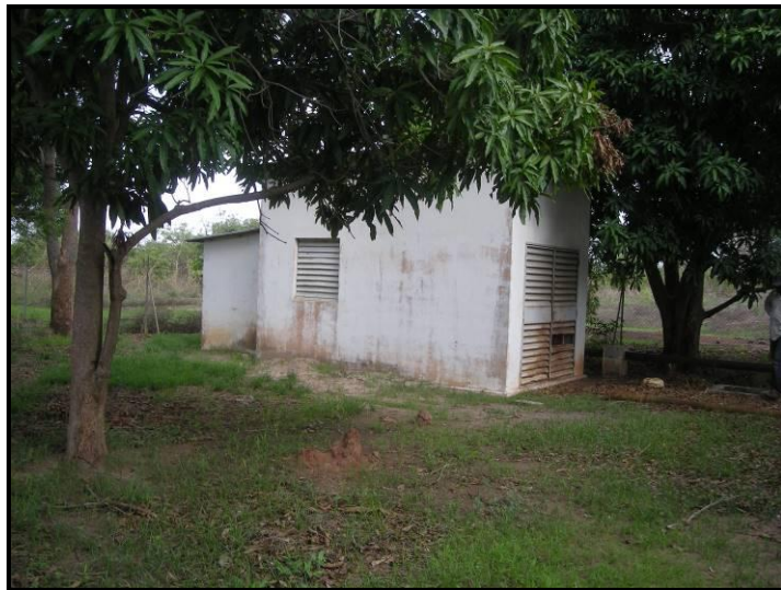
Figure 6. Cabine du groupe électrogène
